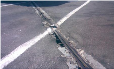
Sconnessioni intorno a griglia/giunto – max 15 gg
