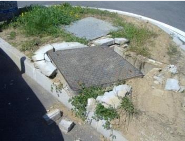
Pozzetto danneggiato – max 15 gg
