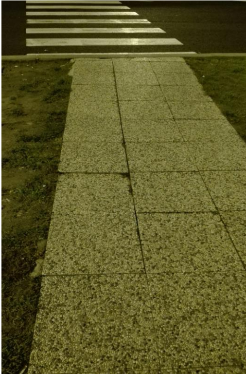
Piastrelle mobili – max 3 mesi ( in caso di elemento mancante o di dislivello evidente max 2 gg)
